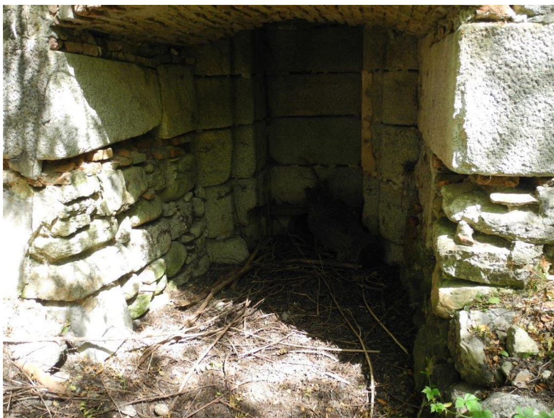
Tronera en el muro de la presa que comunica con el solar de los batanes. Vista desde el sur.
